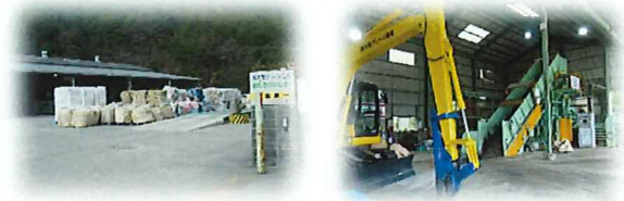
富士リサイクルセンター 敷地面積:9,170㎡ 佐賀県佐賀市富士町大字上熊川 716-3
